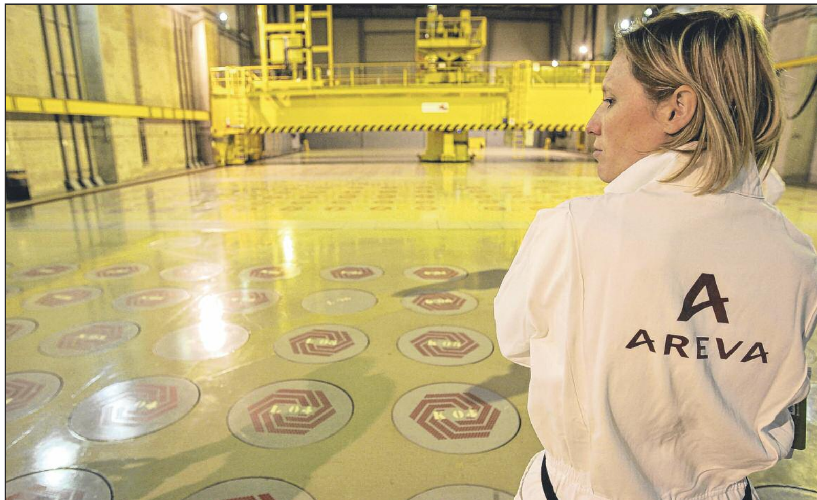
Les déchets vitrifiés issus du retraitement sont entreposés dans des puits ventilés situés sous le plancher de ce grand hall de l'usine de La Hague. KEYSTONE
